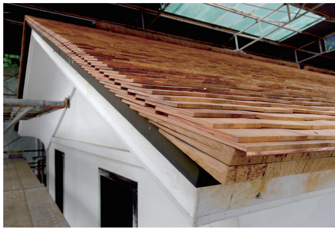
写真3 屋根木賊葺壇置 修理後
