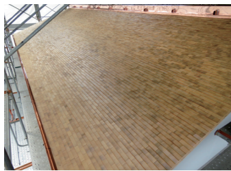
写真5 屋根木賊葺 修理後
