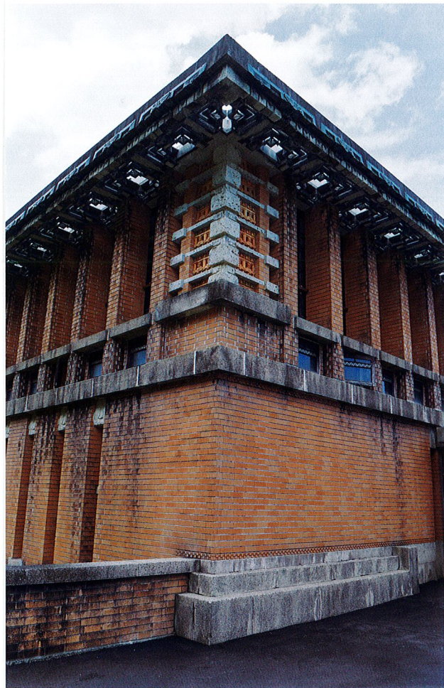
写真3 正面左隅部分
