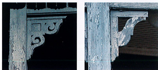
写真2 二階ベランダ柱の持送り
